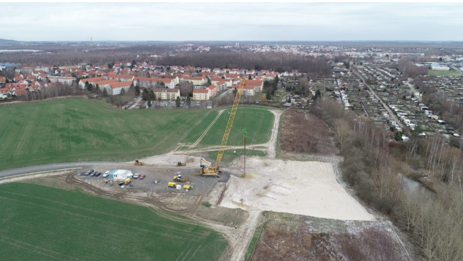
Die Arbeiten auf dem Probefeld im Januar 2019, Archivbild: LMBV
