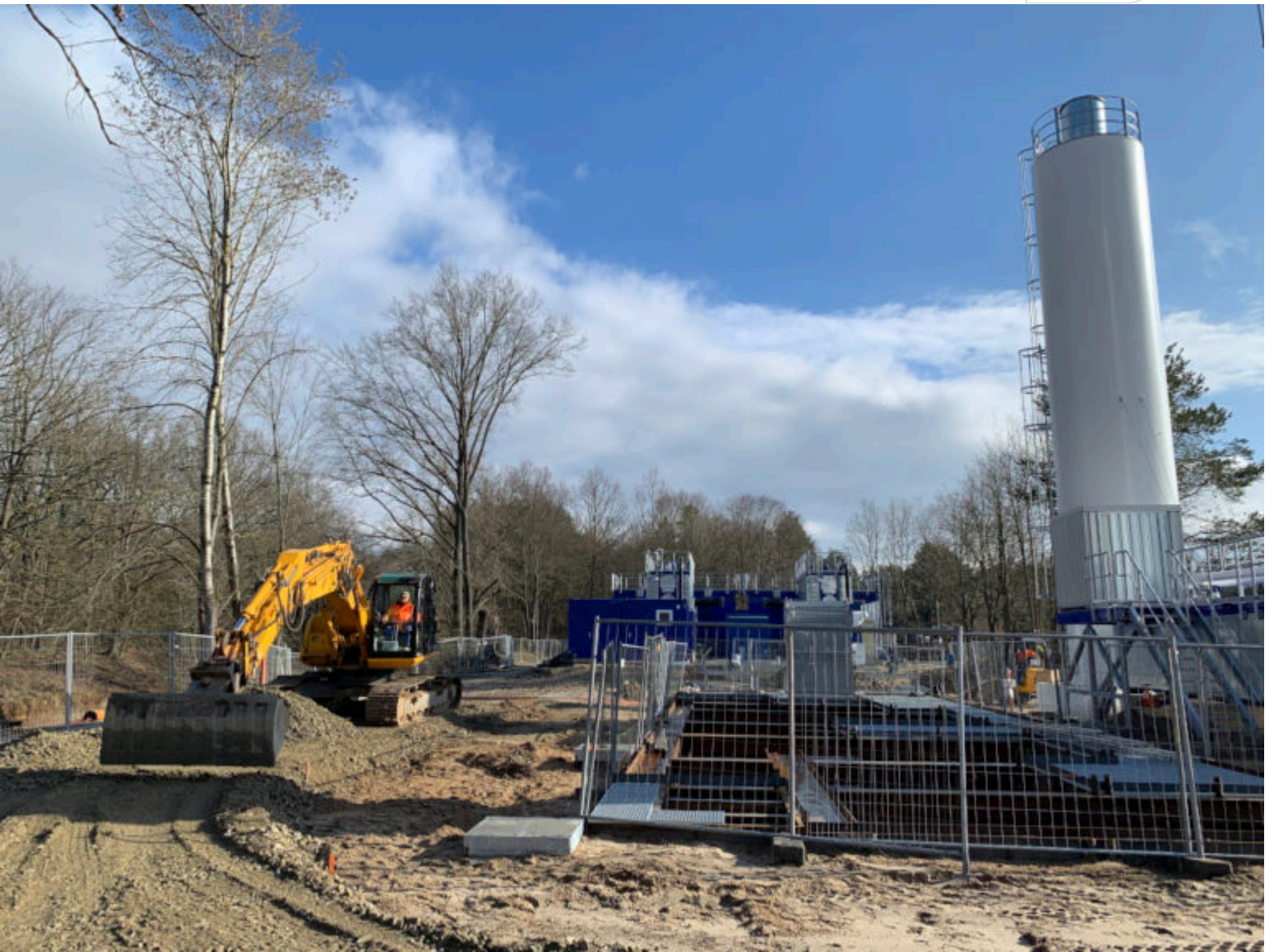
Baufortschritt auf der MWBA-Baustelle
