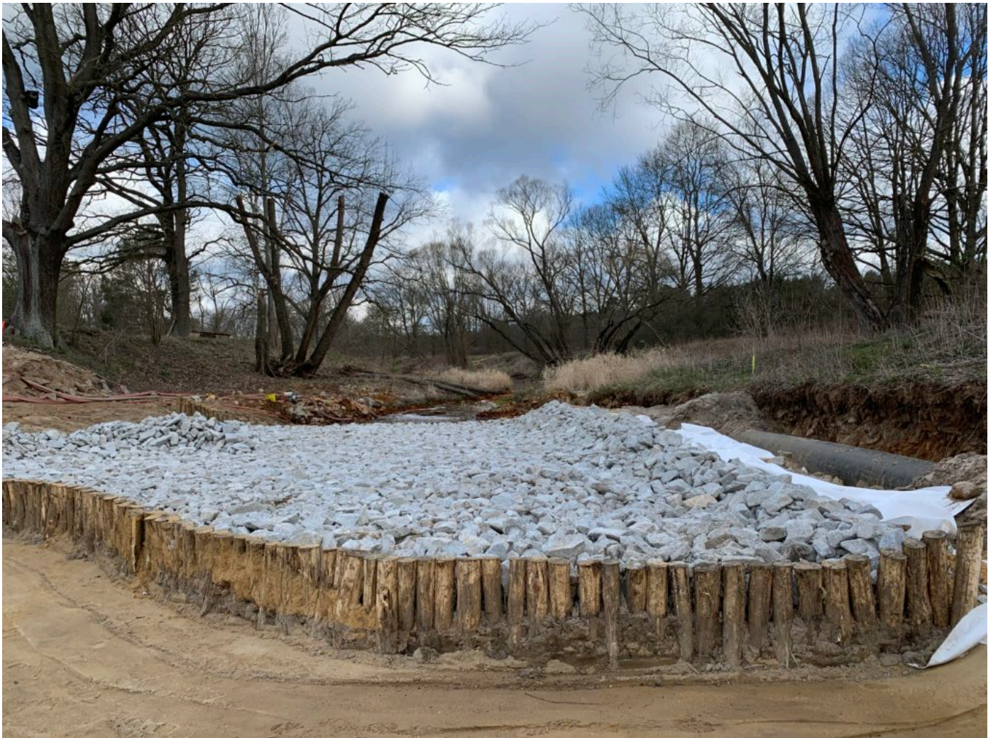
Impressionen vom Bau der MWBA Ruhlmühle im OT Döschko
