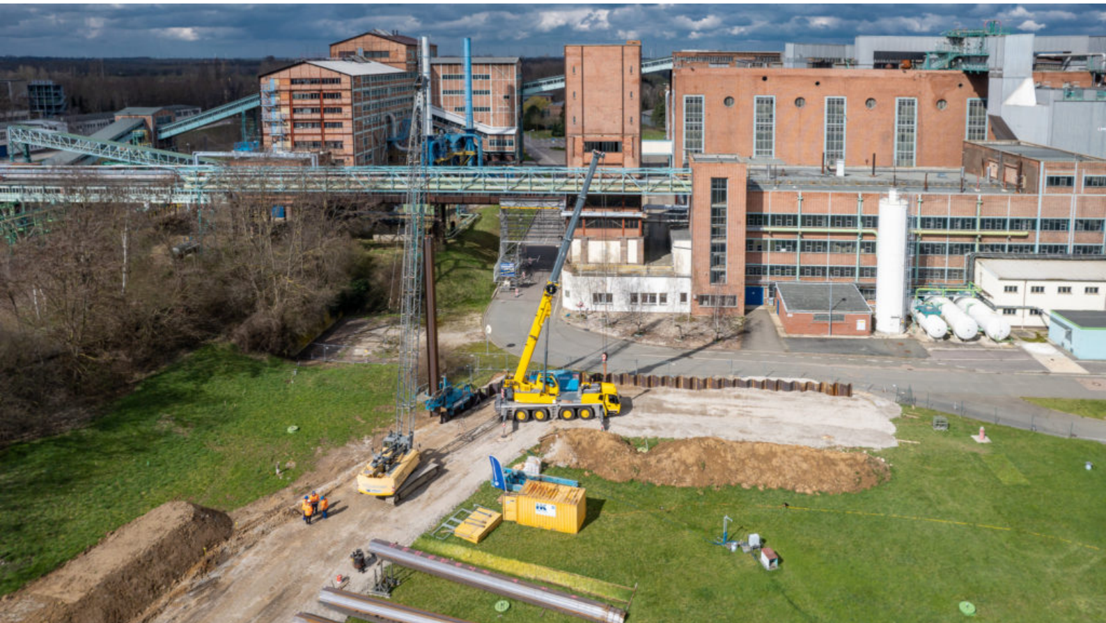
Bau einer Leitwand neben dem ehemaligen Kraftwerk Deuben (Foto: Christian Horn)
