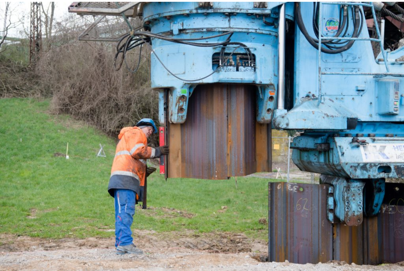
Ausrichten für Einpressen
