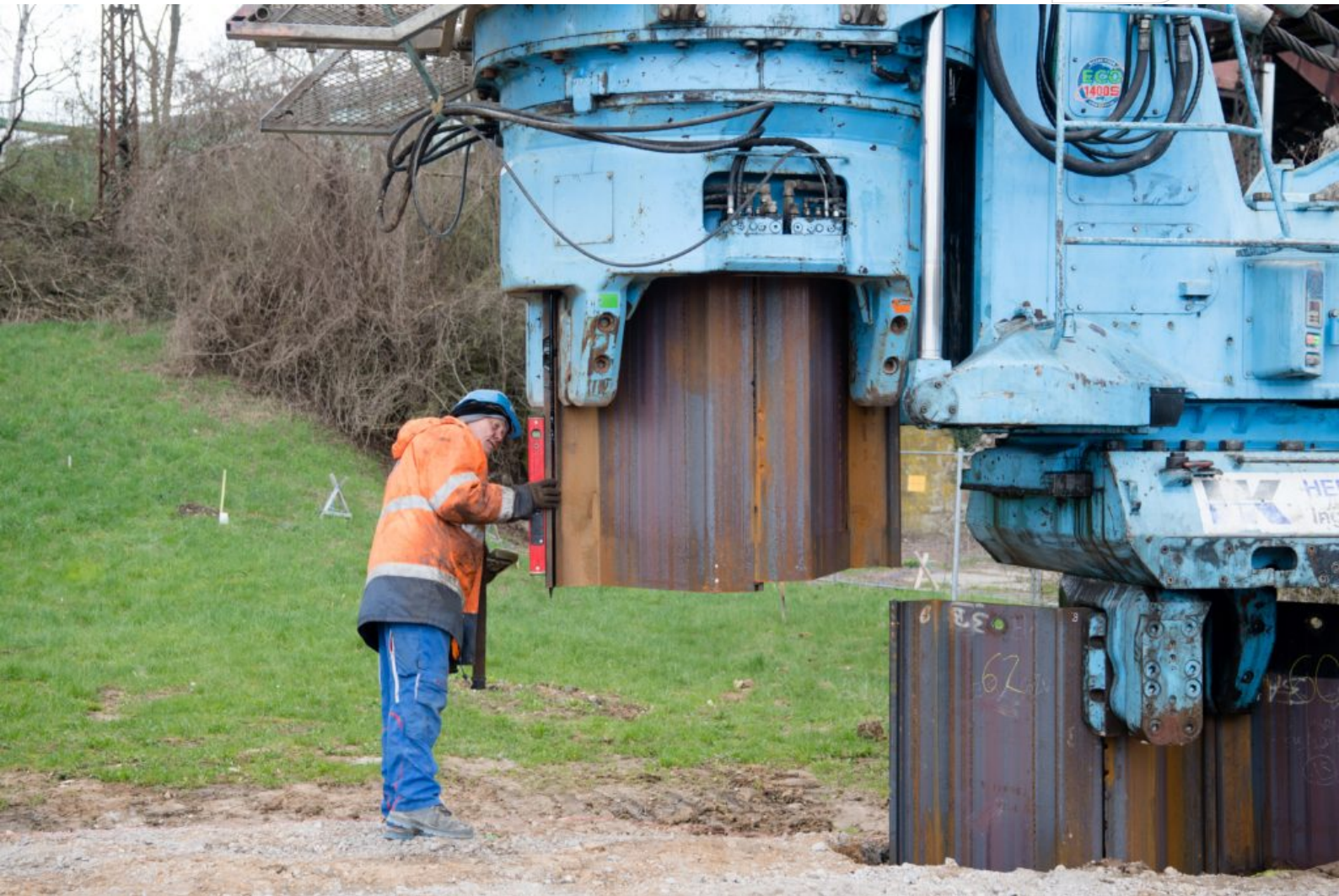
Ausrichten für Einpressen
