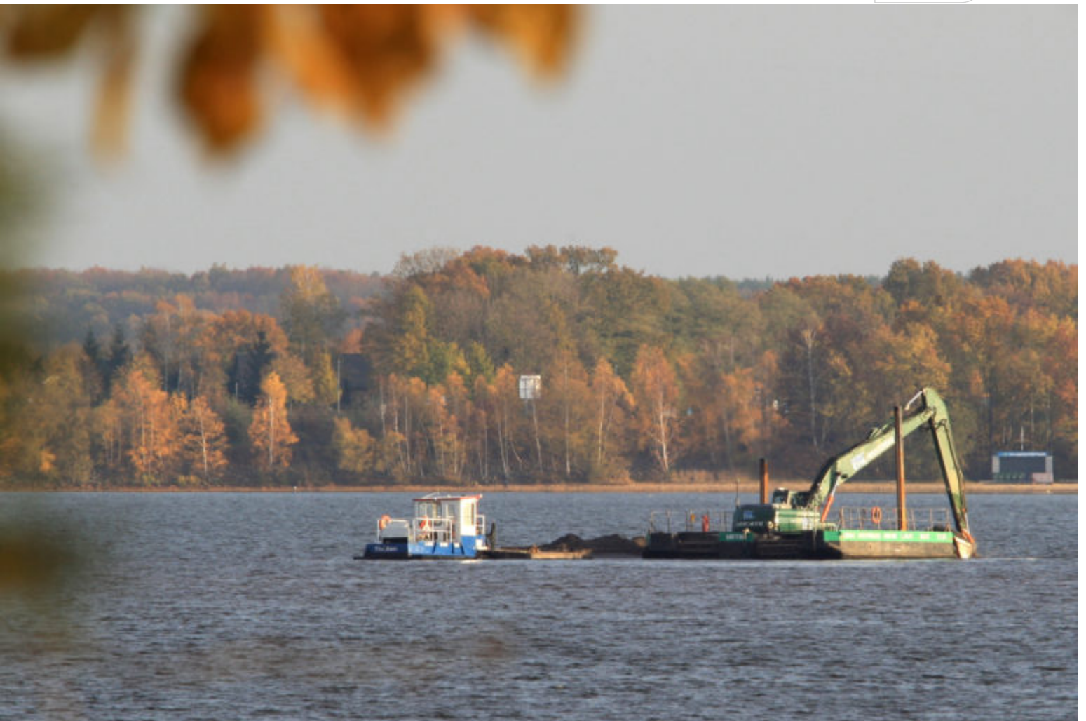
Schwimmbagger der Fa. ETK bei Sofortmaßnahme Teil 2
