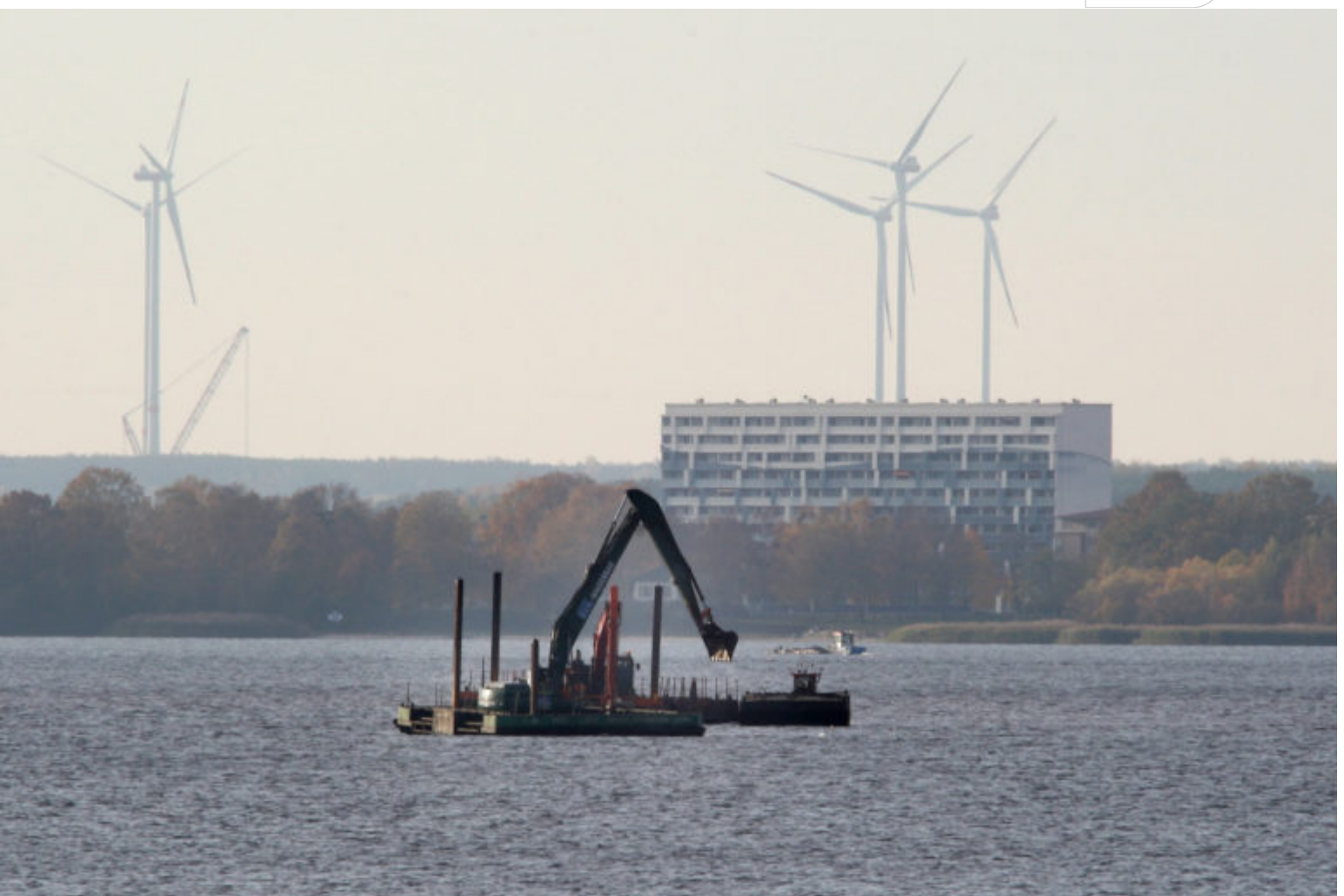
Schwimmende Sanierungstechnik im Nov. 2019 auf dem Senftenberger See
