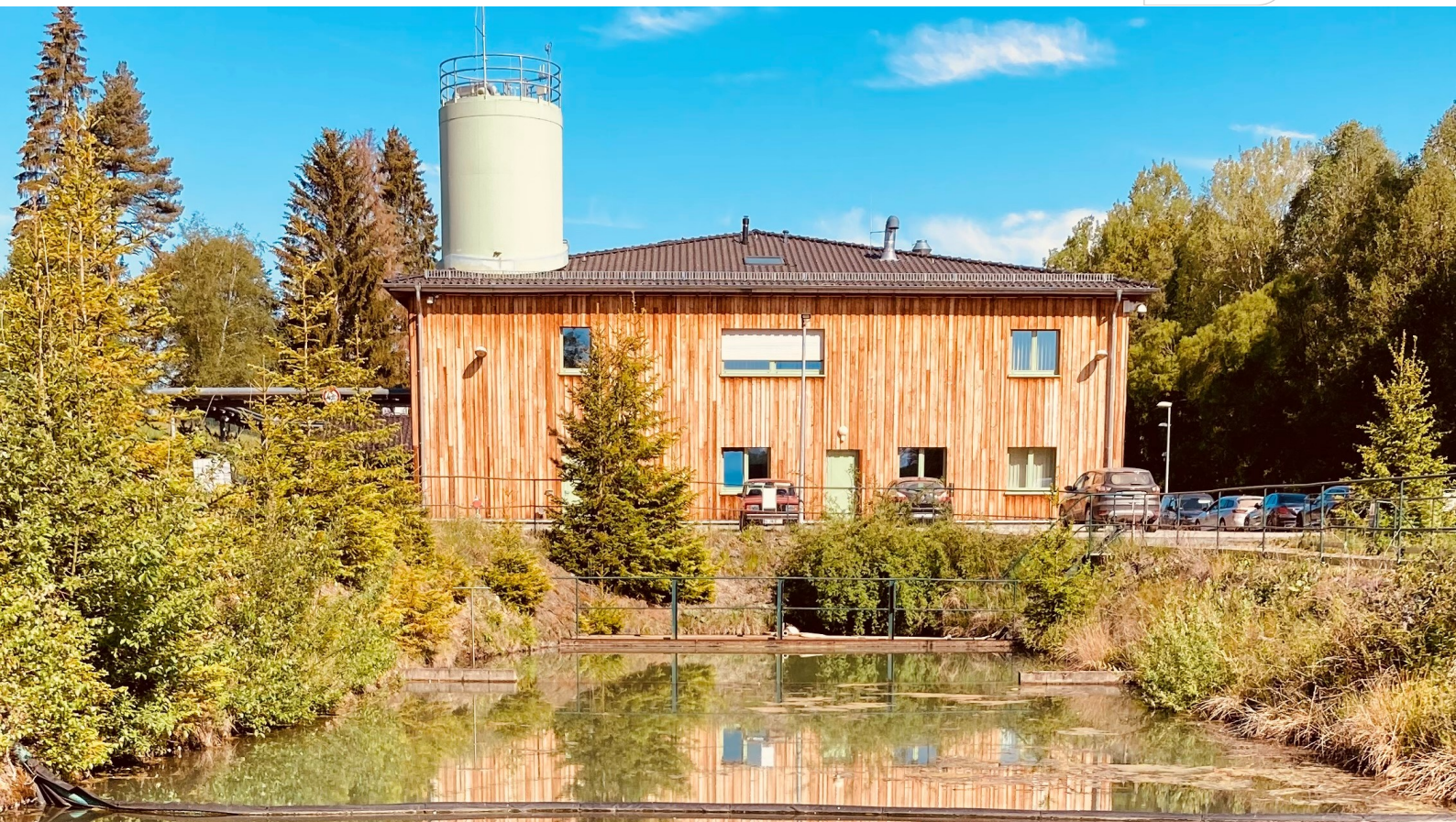
Betriebsgebäude GWRA Uhlenbachtal
