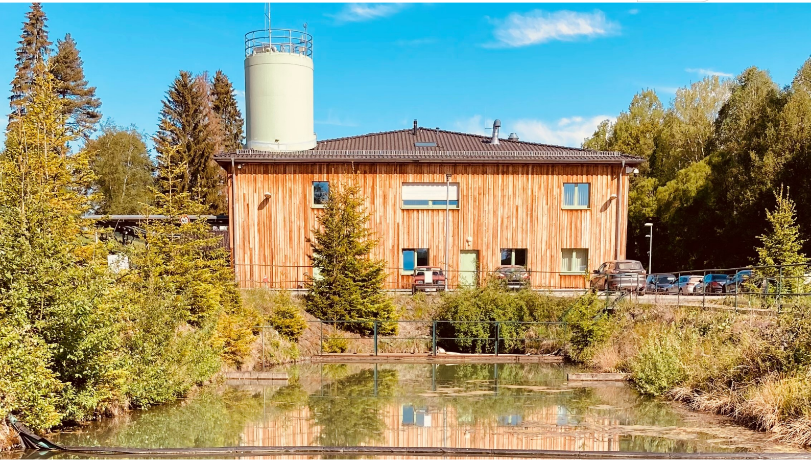
Betriebsgebäude GWRA Uhlenbachtal
