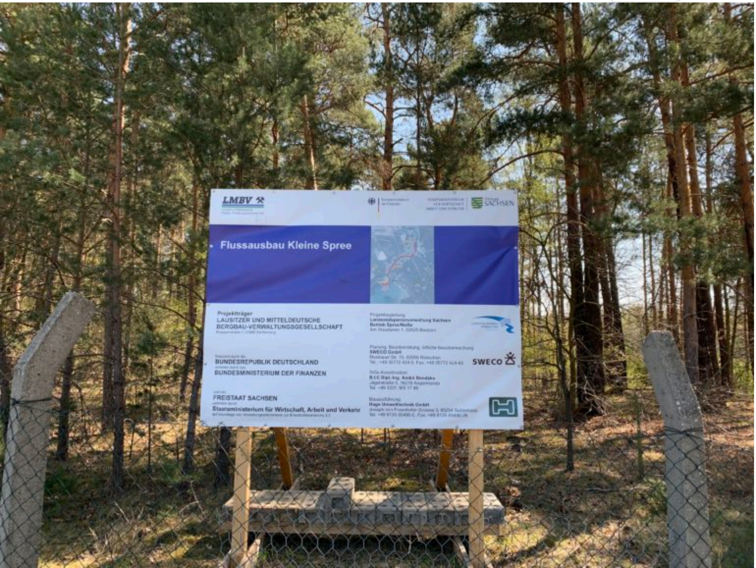
Bauschild zum Ausbau der Kleinen Spree
