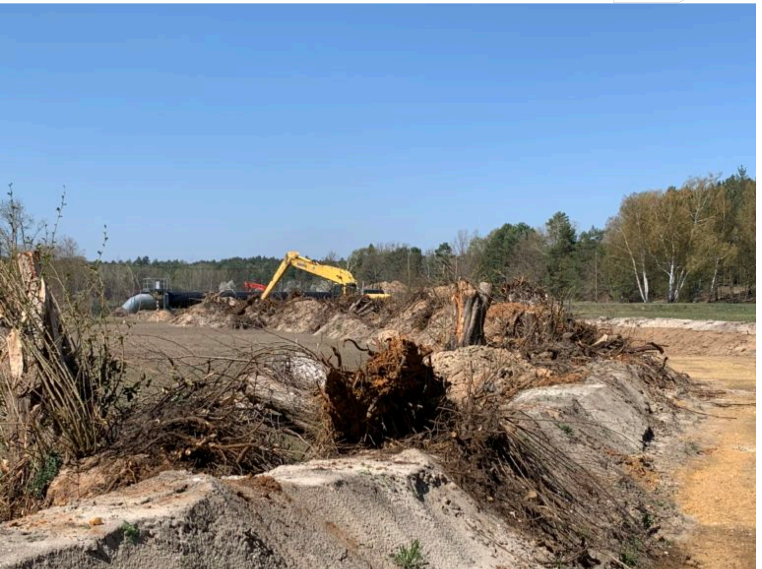
Abschnitt III zur Entschlammung der Kleinen Spree
