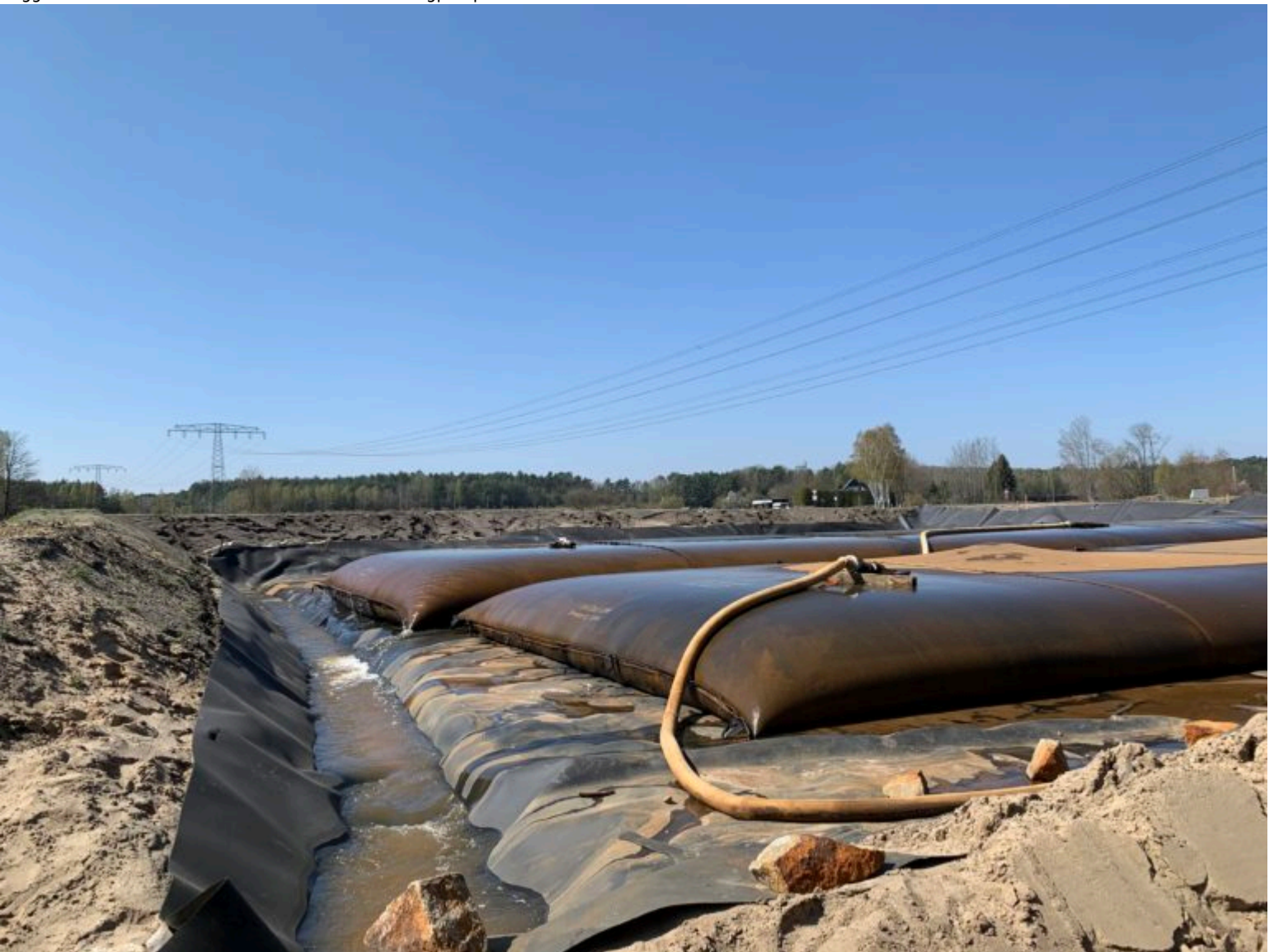
Geotubes im Einsatz am Abschnitt III zur Entschlammung der Kleinen Spree
