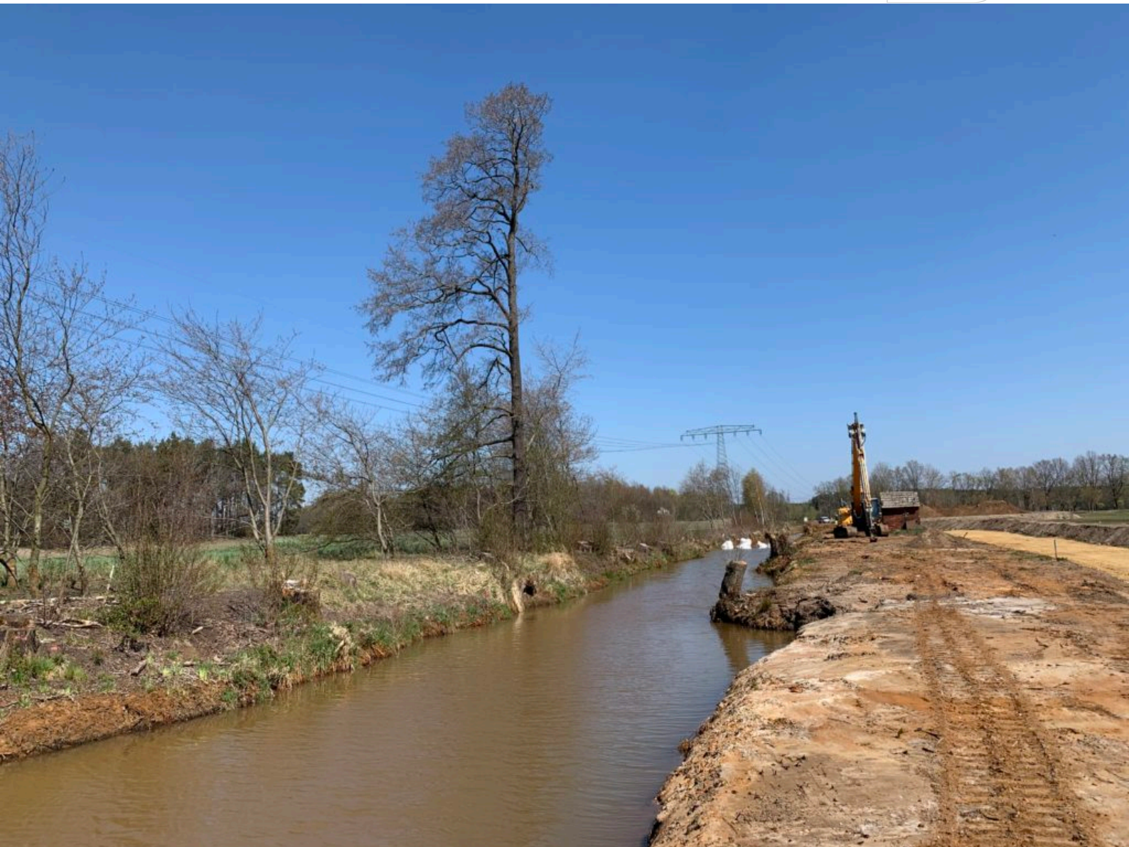
Bereits entschlammter Flussabschnitt der der Kleinen Spree bei Spreewitz
