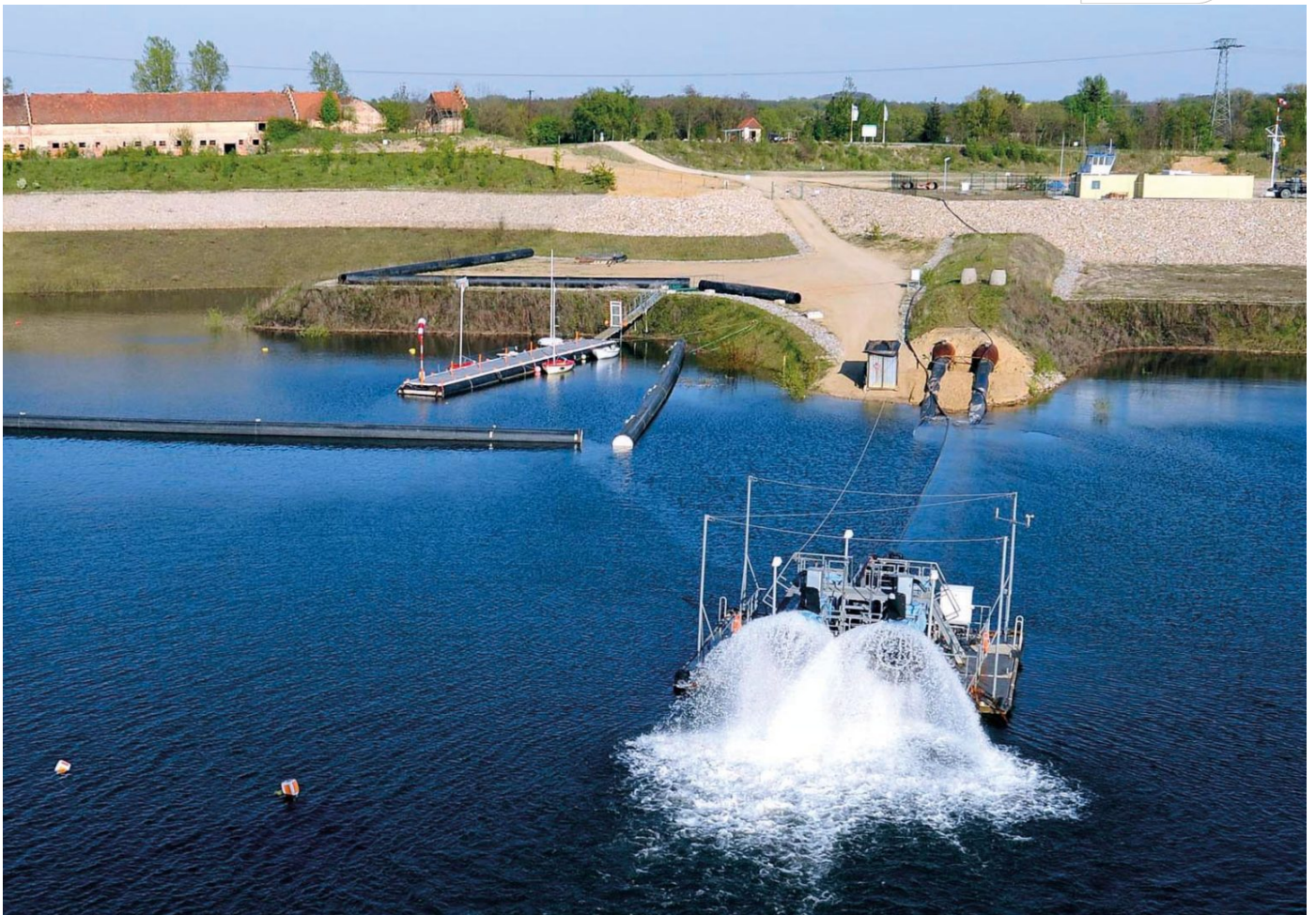
Flutungsleitung im Berzdorfer See
