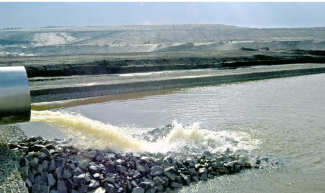
Flutungsleitung zum Großräschener See (2007)
