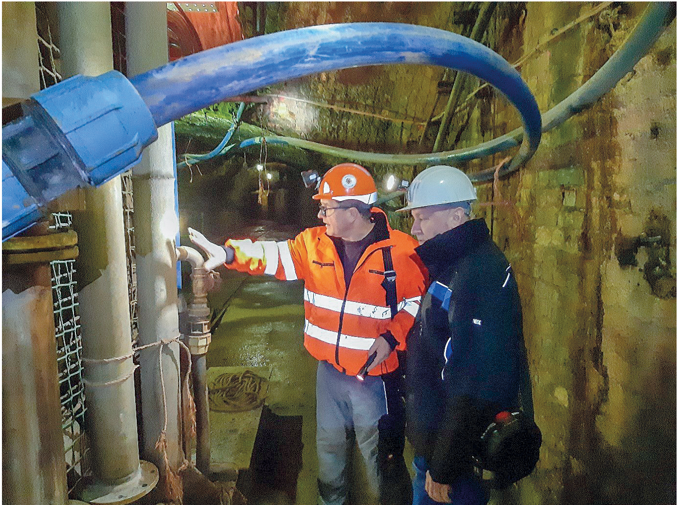
Begehung des Zentralschachtes im Bergwerk Elbingerode
