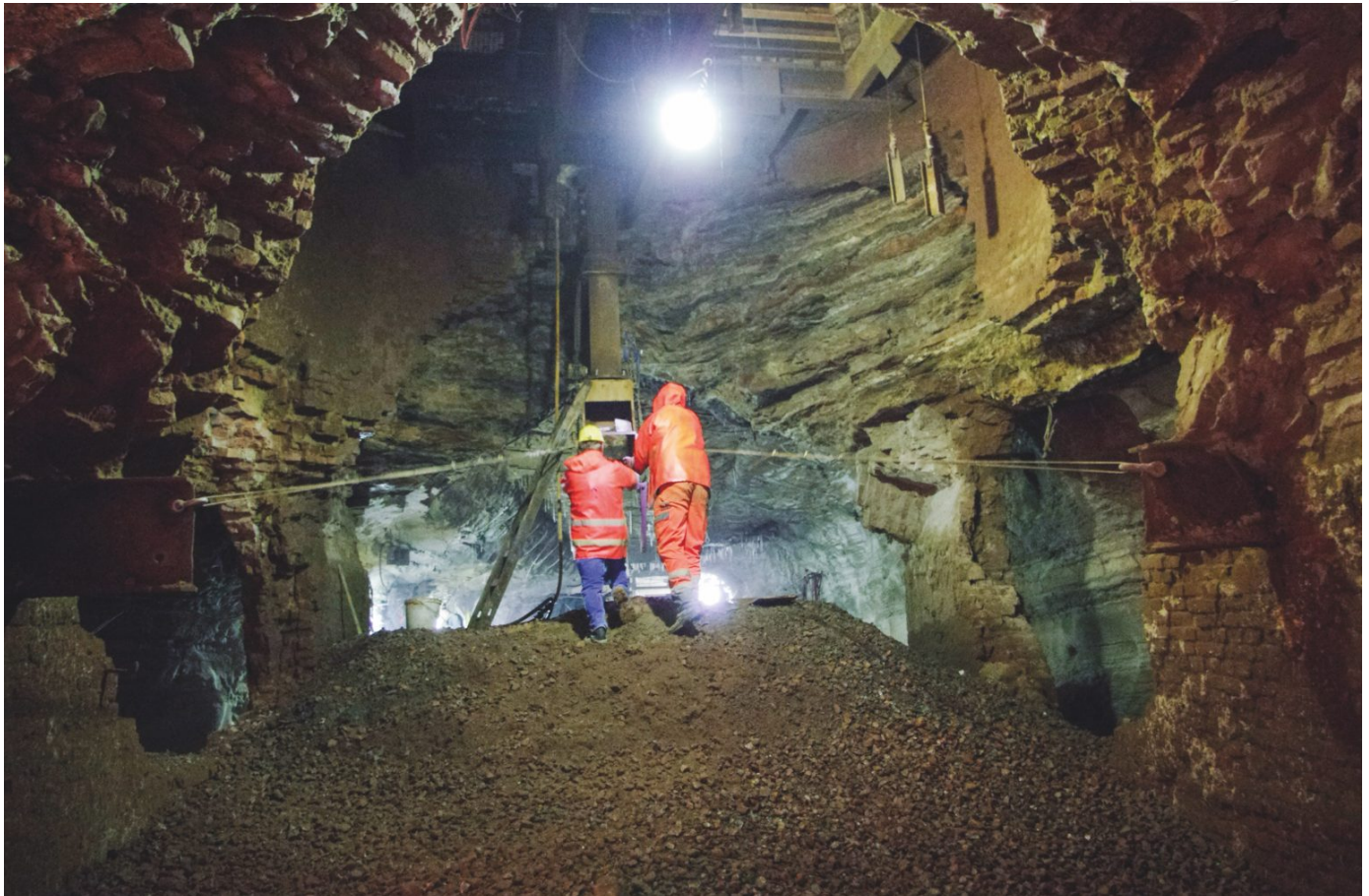
Verwahrung von Schächten im Bergwerk Bischofferode, 2015
