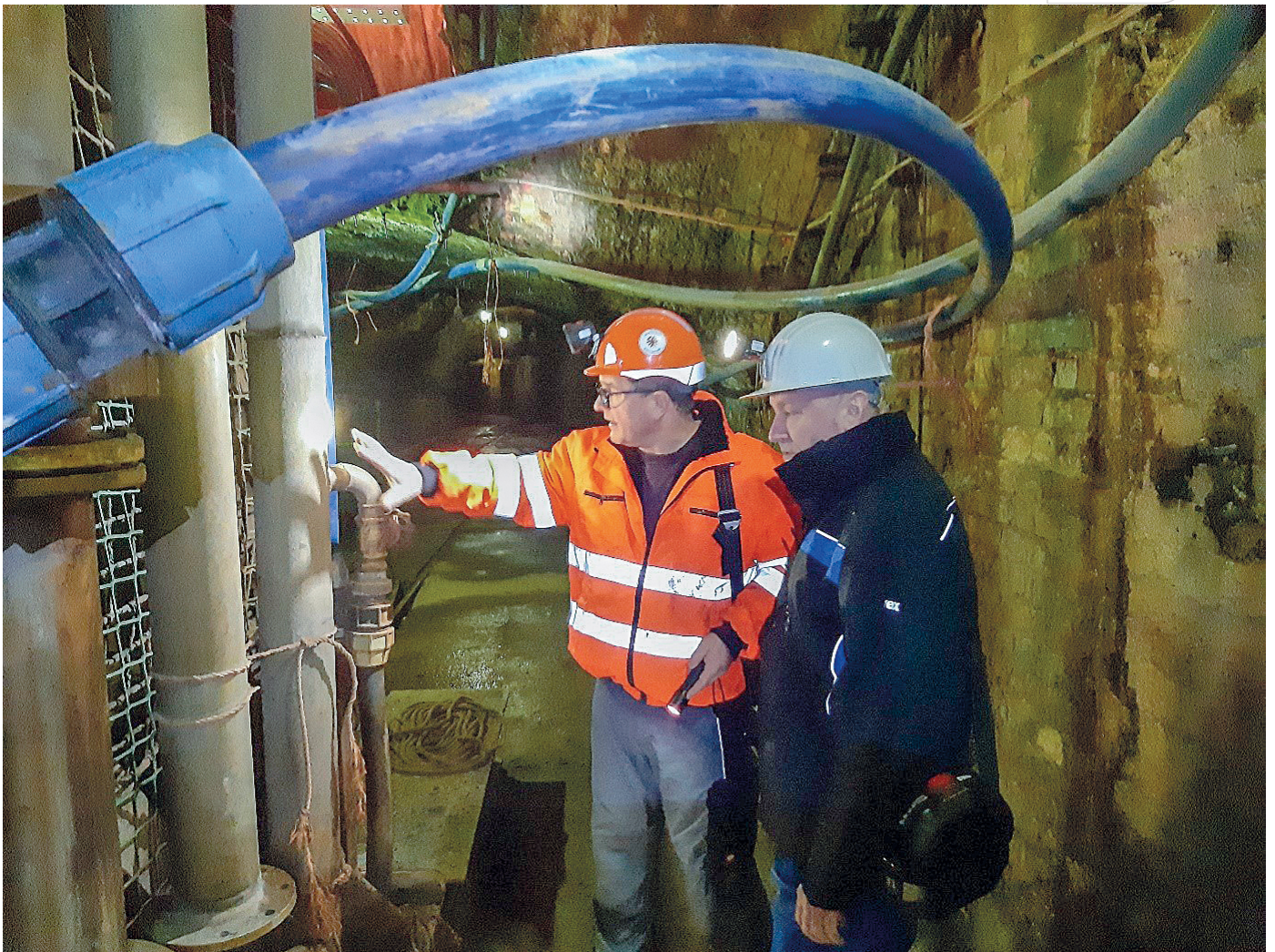
Begehung des Zentralschachtes im Bergwerk Elbingerode
