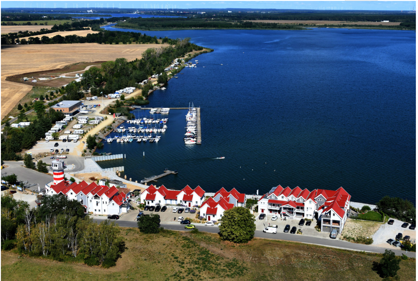
Marina und Wasserwanderrastplatz am Geierswalder See
