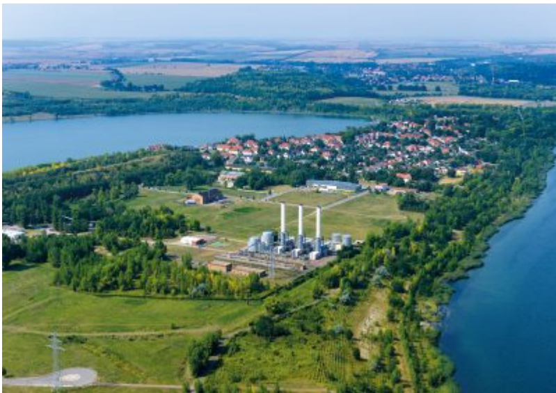
Mitteldeutscher Industriepark Großkayna
