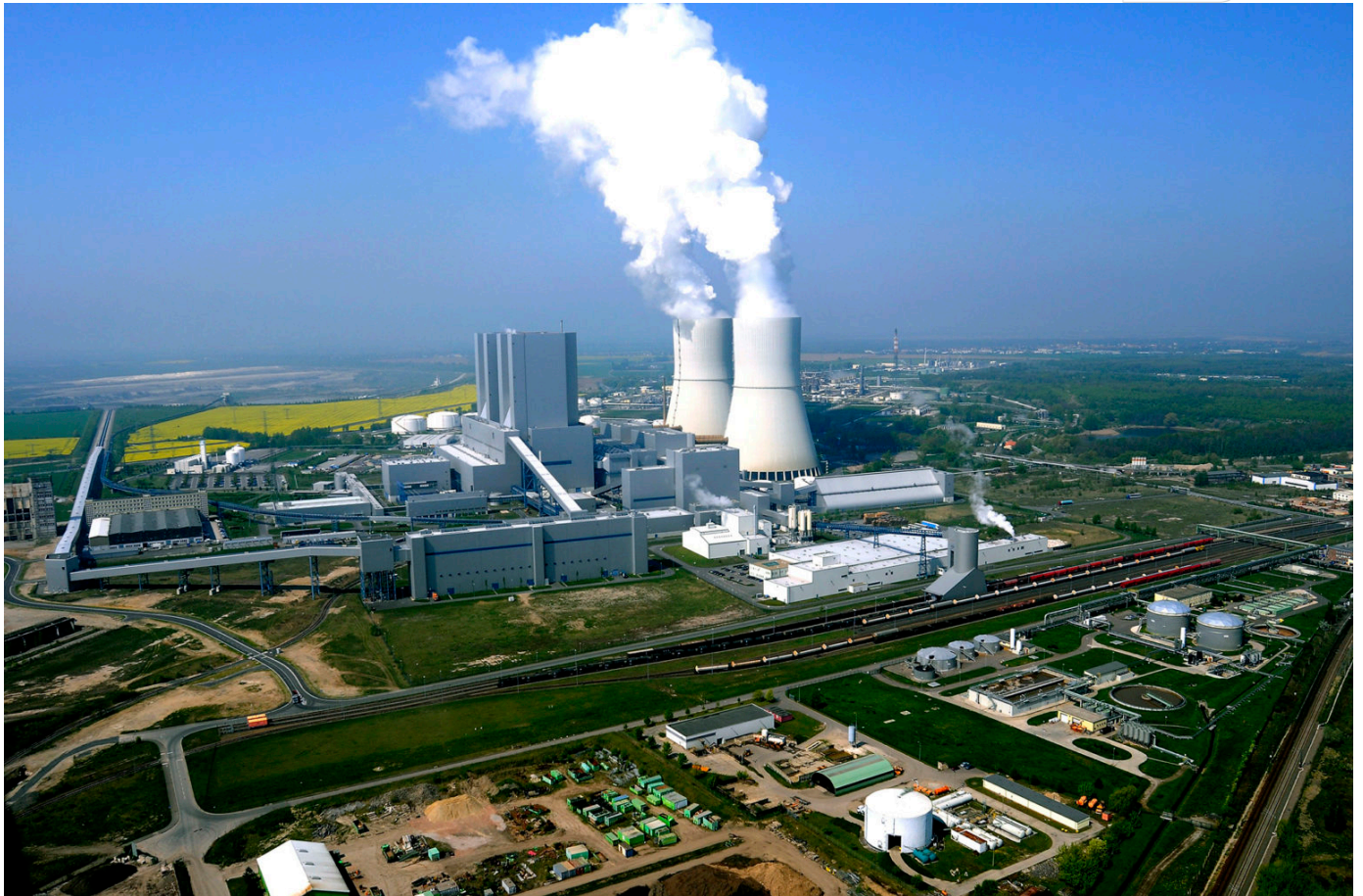
Industriepark Schwarze Pumpe
