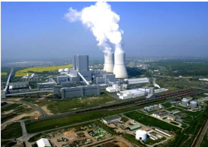
Industriepark Schwarze Pumpe
