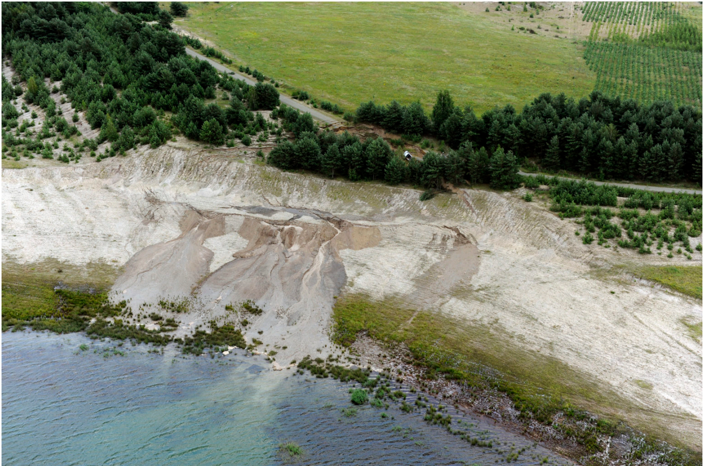
Rutschung am Speicherbecken Lohsa II (2012)
