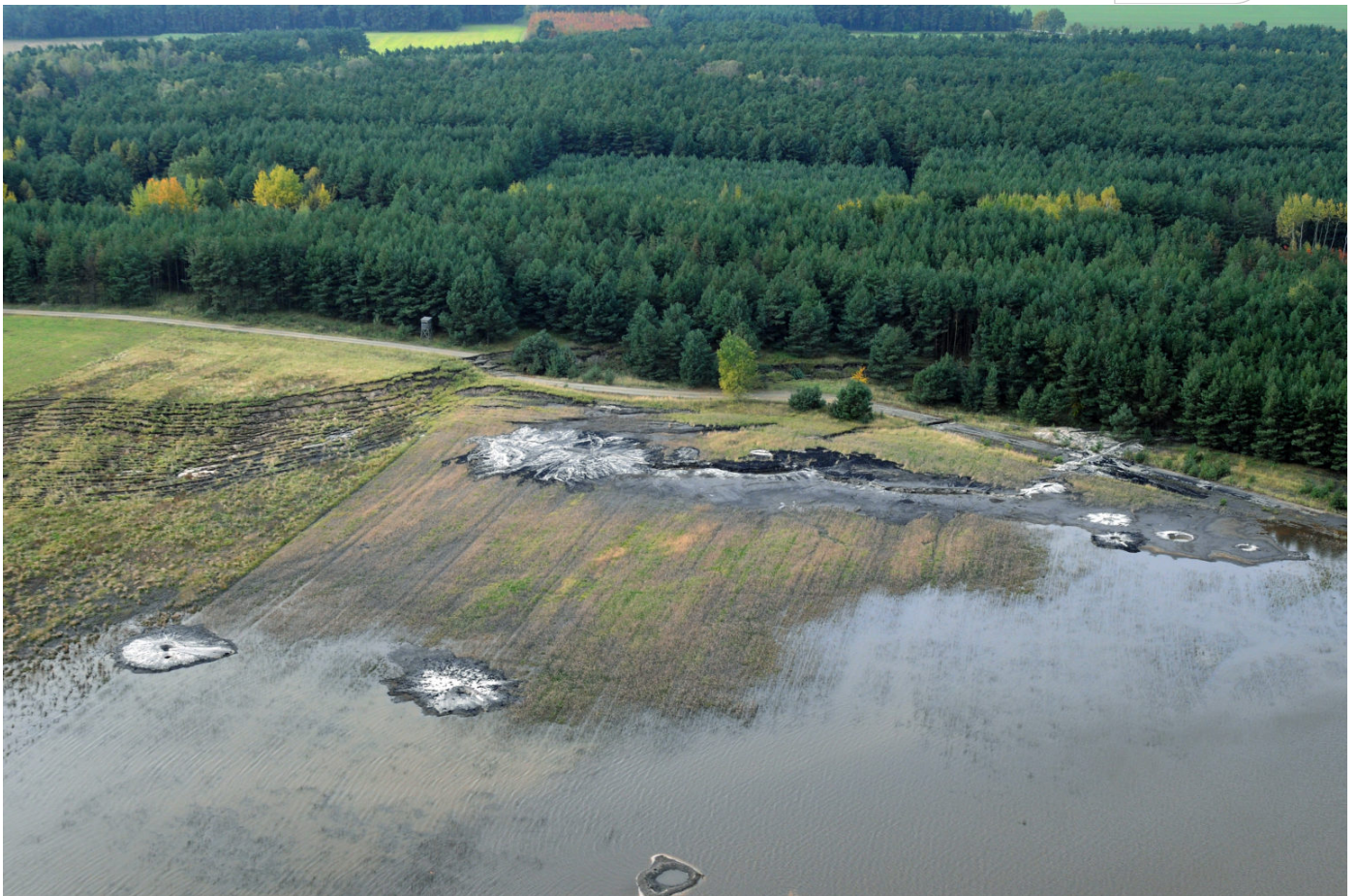
Grundbruch im Bereich Spreetal (2010)
