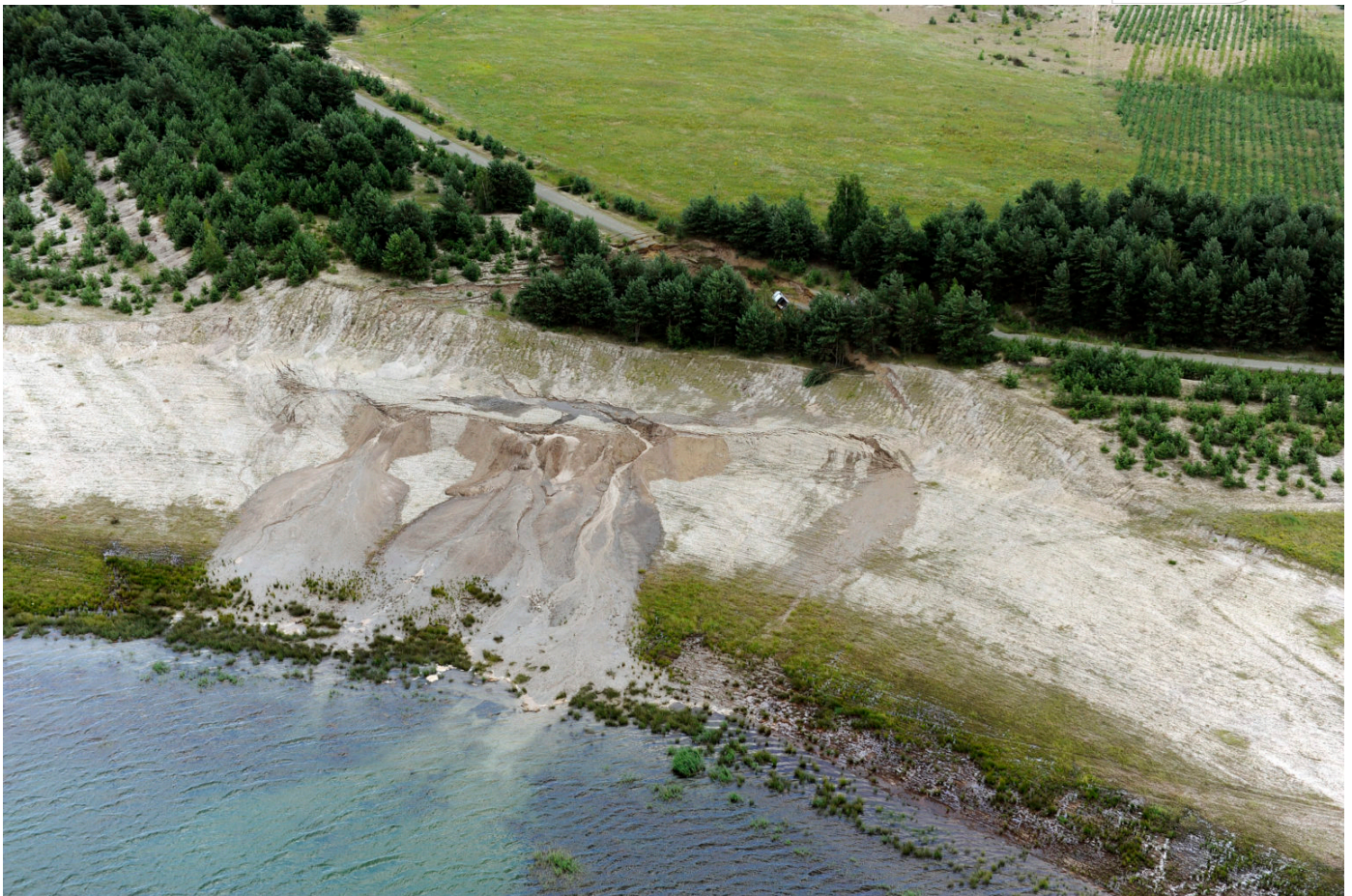
Rutschung am Speicherbecken Lohsa II (2012)
