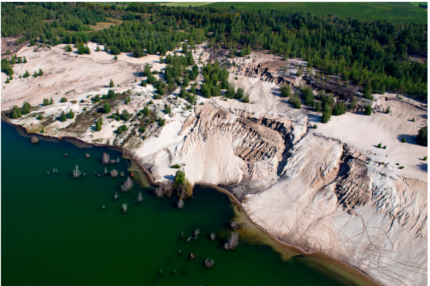
Sanierung der Ostböschung des Lappwaldsees
