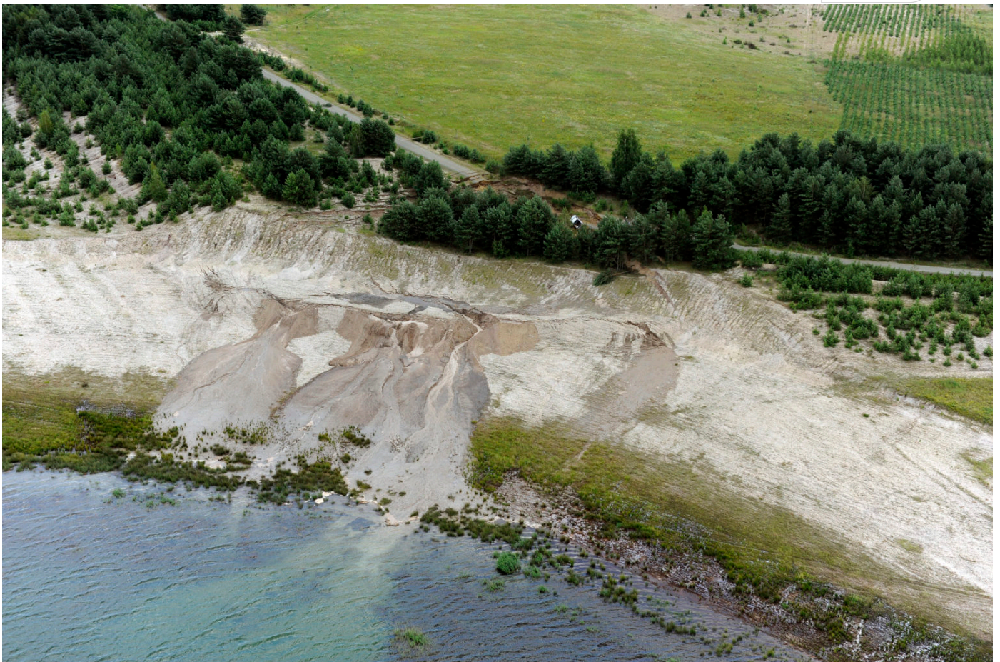
Rutschung am Speicherbecken Lohsa II (2012)
