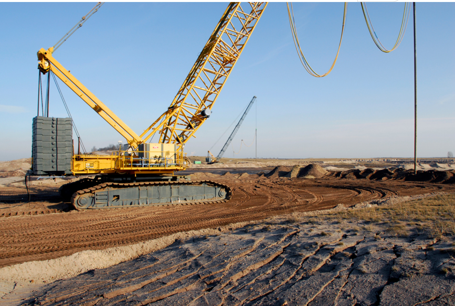
Einsatz von Rütteldruckverdichtung in der Lausitz (2012)
