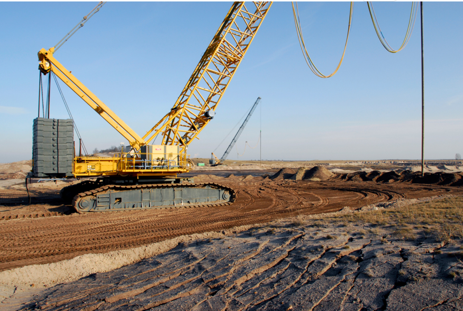
Einsatz von Rütteldruckverdichtung in der Lausitz (2012)
