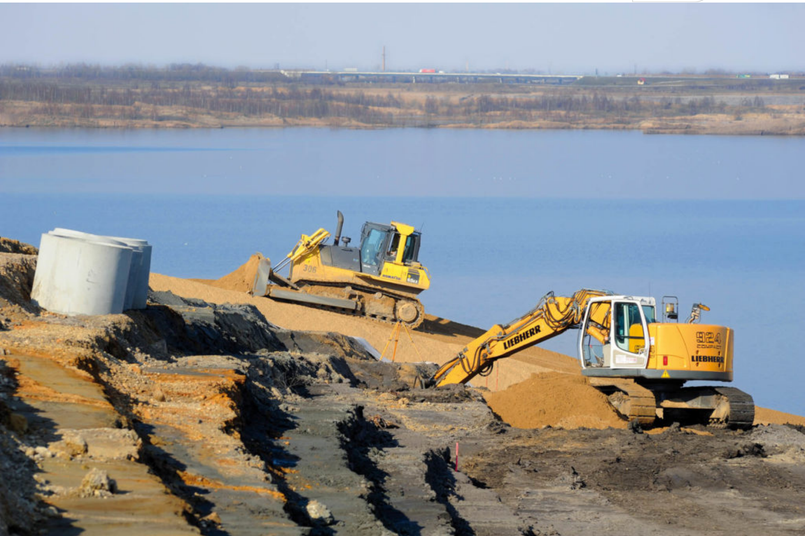
Bau der Hochwasserentlastung Zitzschen am Zwenkauer See, 2011 (Foto: Ch. Bedeschinski)
