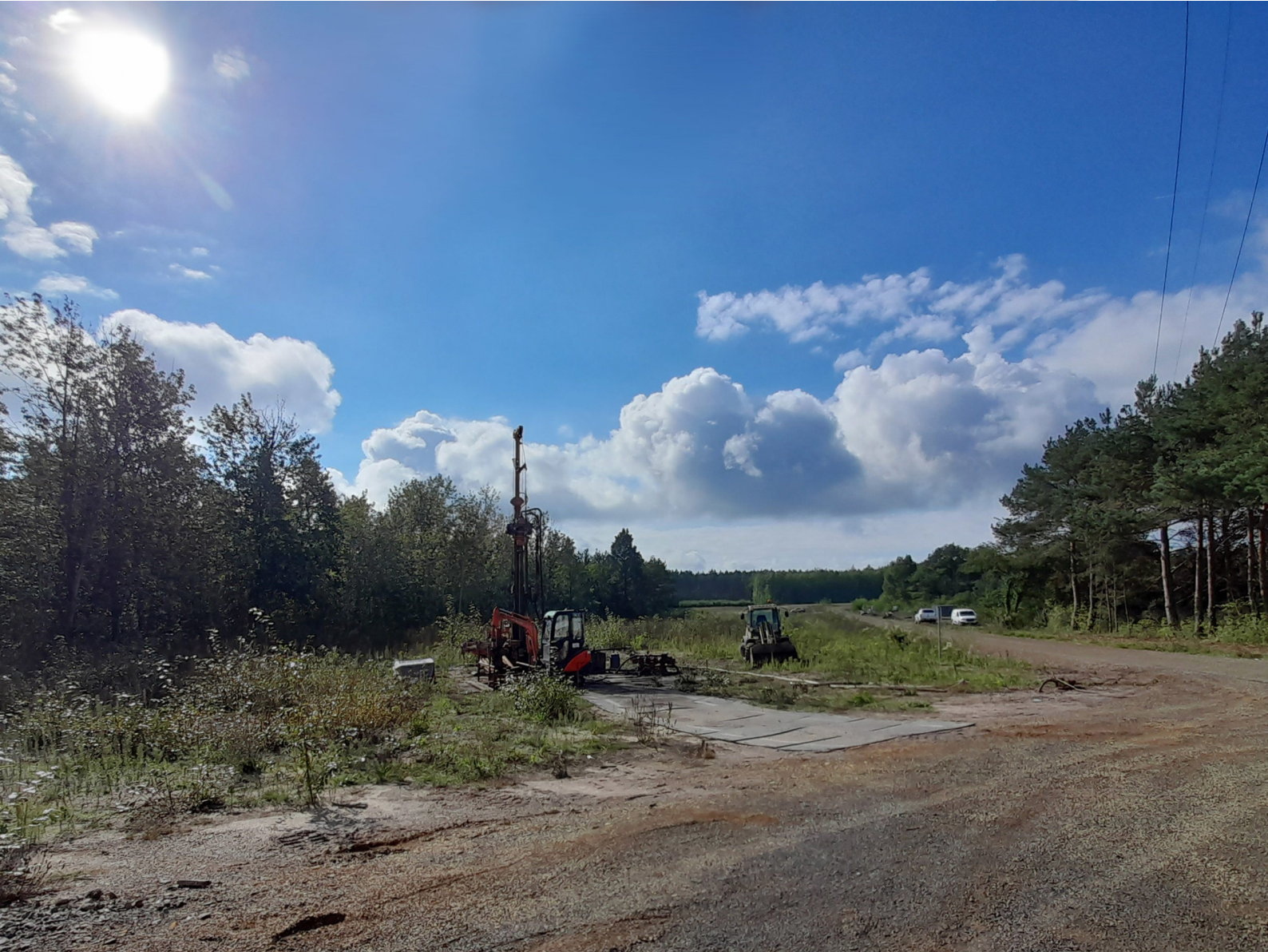
Filterbrunnenverwahrung auf der Brückenfeldkippe
