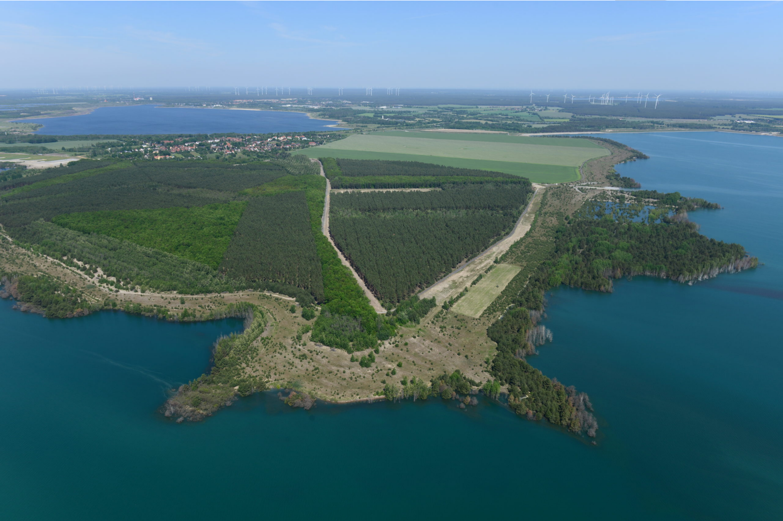
Brückenfeldkippe von oben
