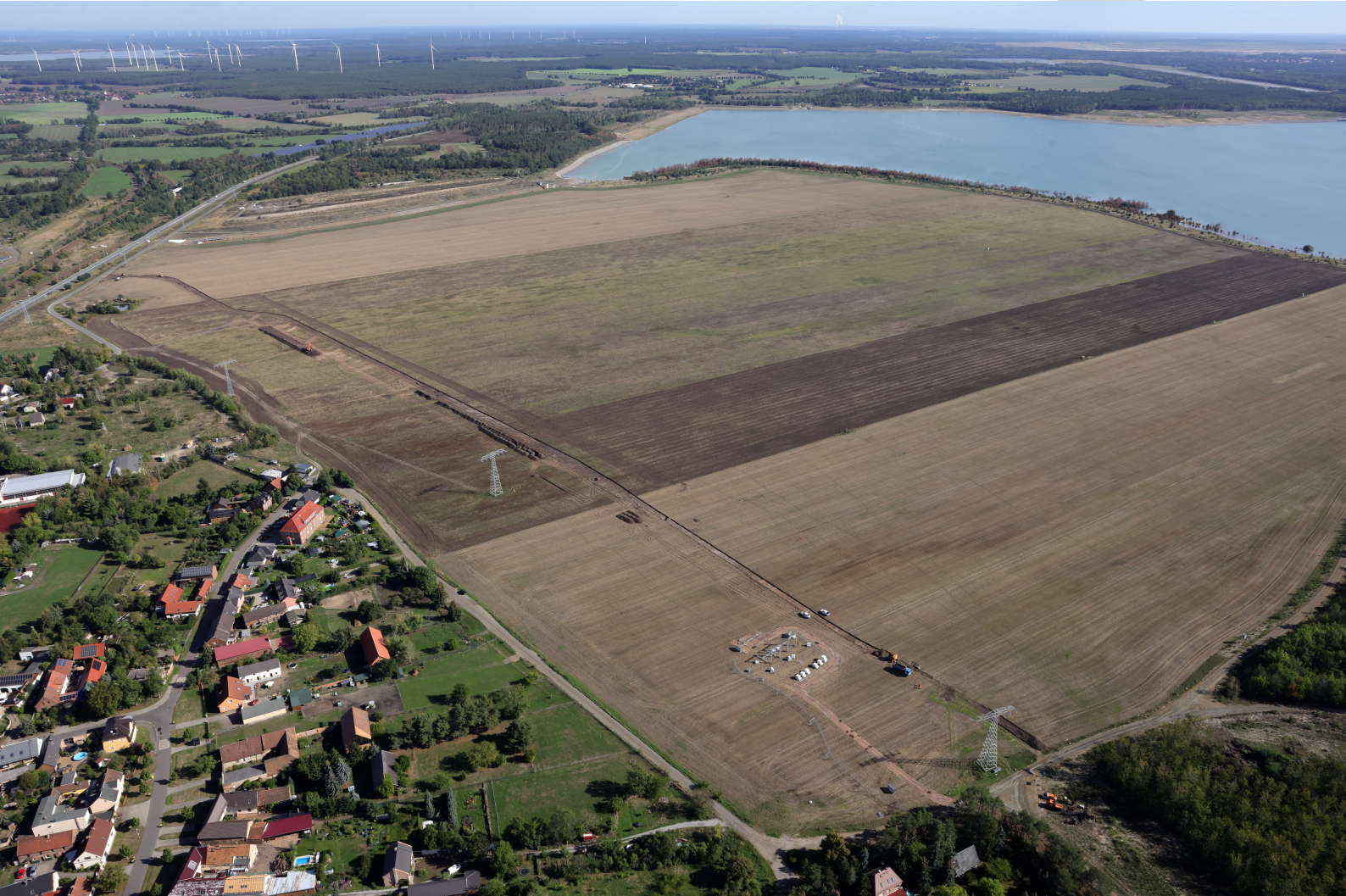
Errichtung der Nordzufahrt zu Brückenfeldkippe Sedlitz
