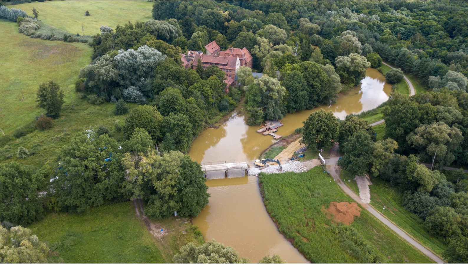
Ersatzneubau der Austragsleitung an der Konditionierungsanlage Wilhelmsthal
