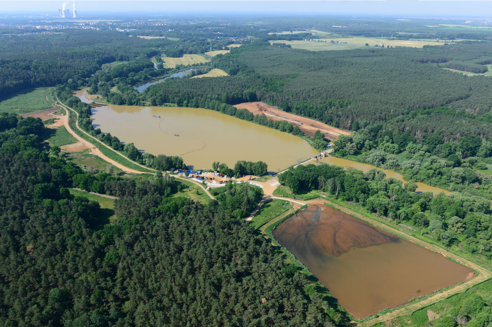
Sedimentationsbecken an der Vorsperre Bühlow
