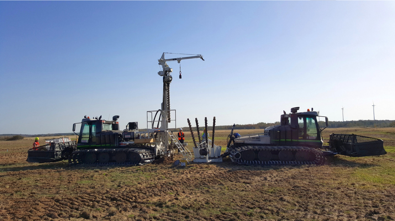
Schonende Sprengverdichtung / Foto: Dieter Kutzschbach
