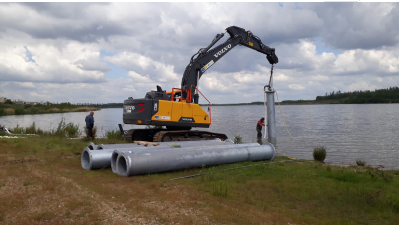
Dalben werden in den Seeuntergrund eingebracht. (Bild: Anglerverband Leipzig / Richter)
