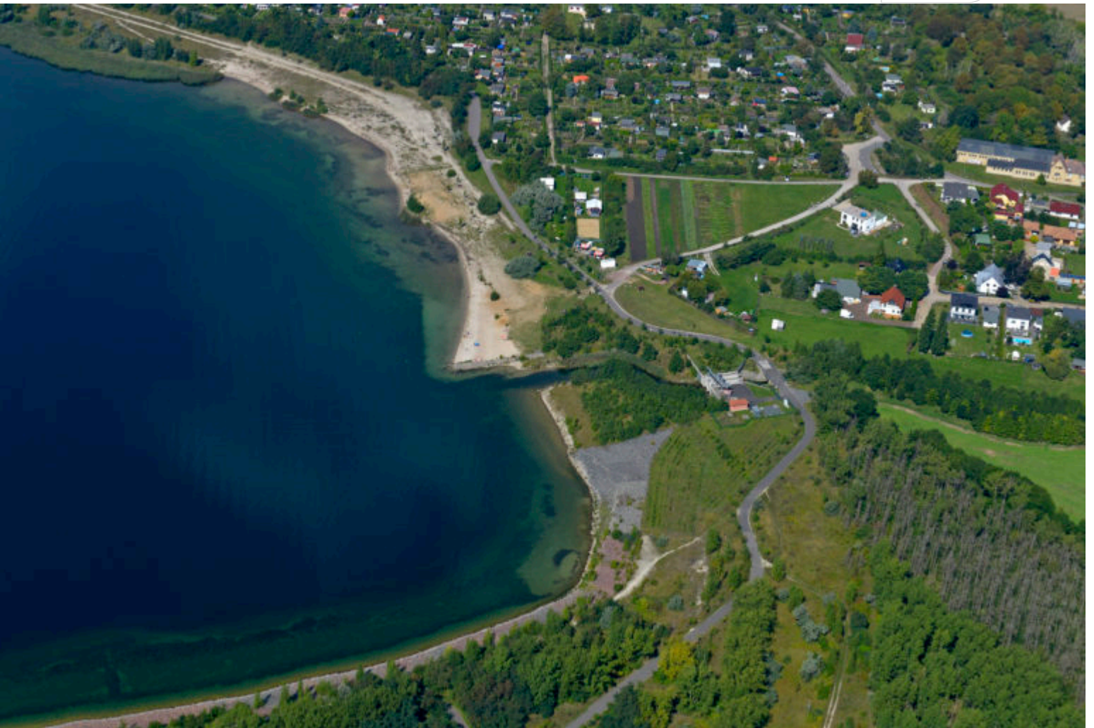
Geiseltalsee: Uferbereich Frankleben mit Auslaufbauwerk (Foto: 6. September 2021).
