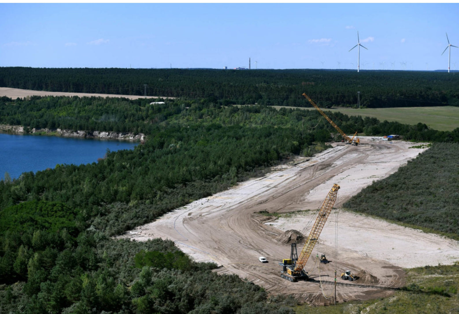
RDV-Bagger am RL Greifenhain - Kippenböschungsverdichten am Atdöberner See
