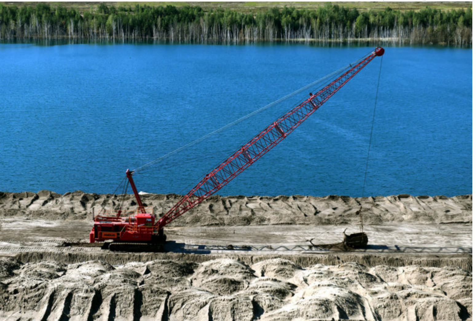
Seilbagger am Ufer des Klinger Sees
