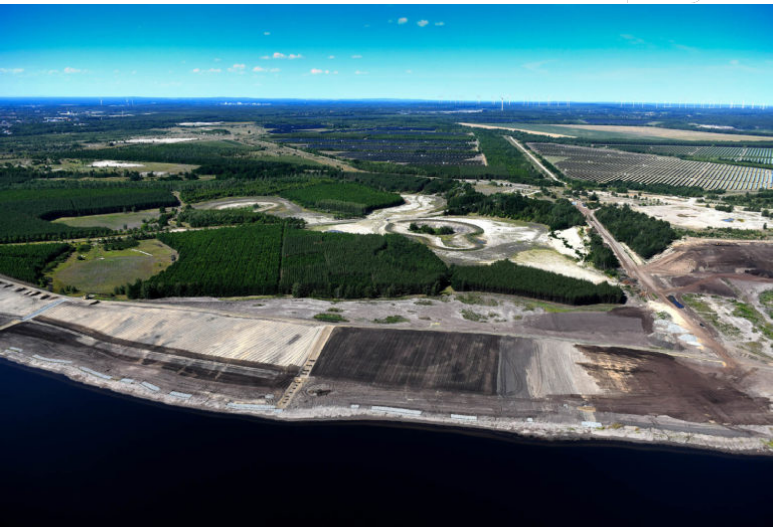
Böschungssicherung RL Meuro
