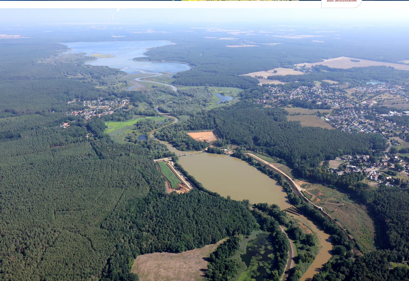
Blick auf die Talsperre Spremberg
