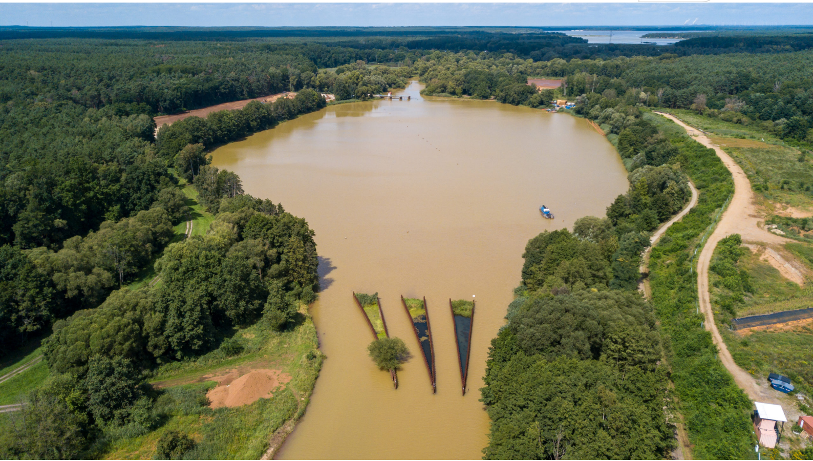
Blick auf die Vorsperre Bühlow
