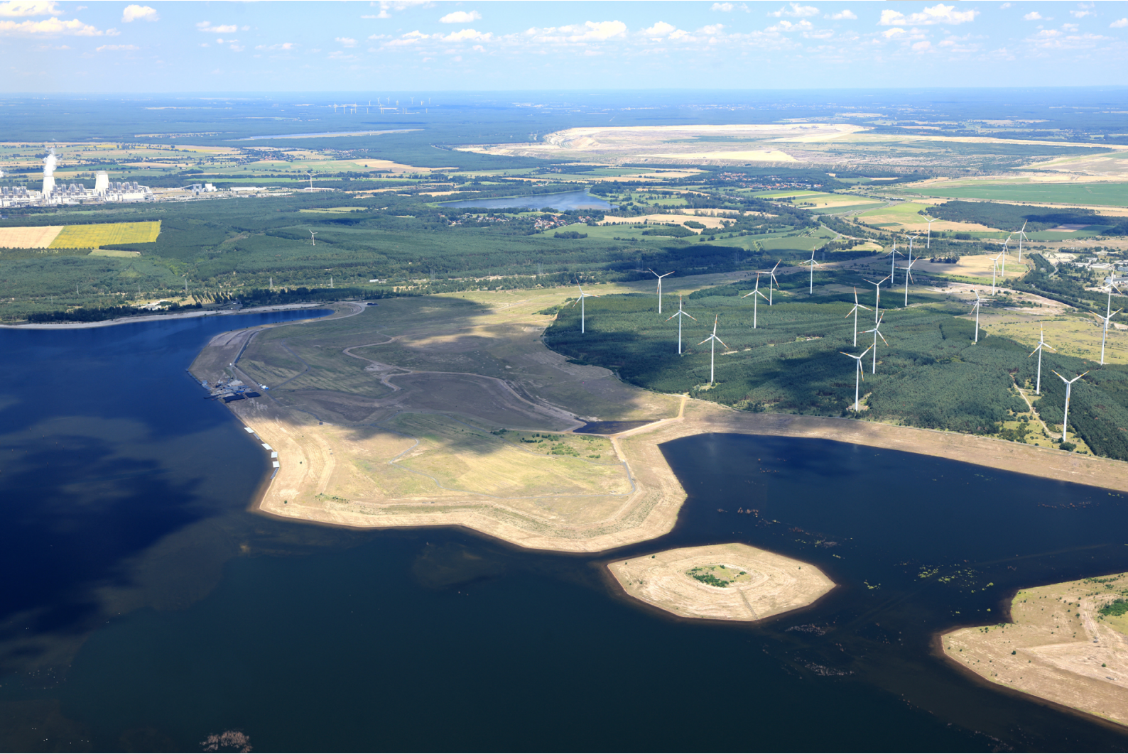
LMBV-Bereich am Cottbuser Ostsee
