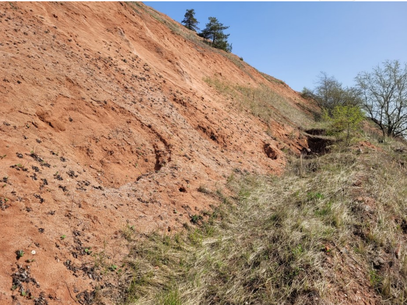
Ehemalige Haldenauffahrt mit Auslaugungstrichtern vor Instandsetzung
