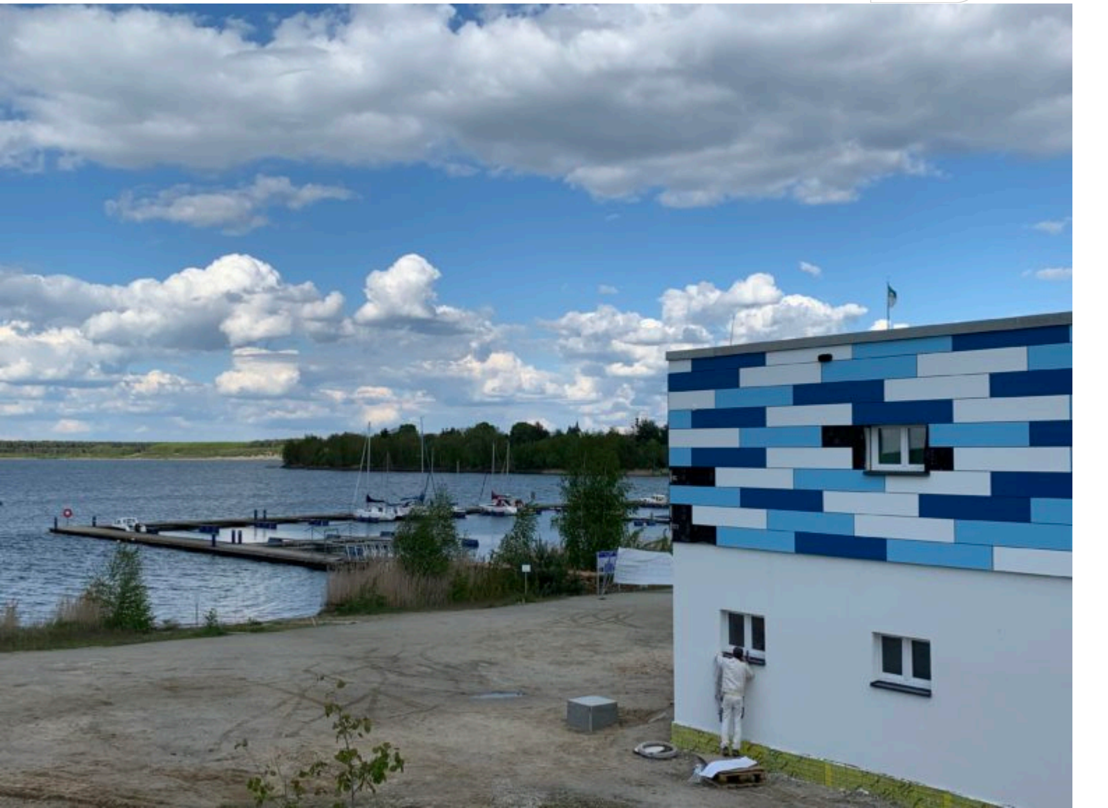
Investition von ZV LSS und LMBV am Bergbaufolgesee im Wachsen
