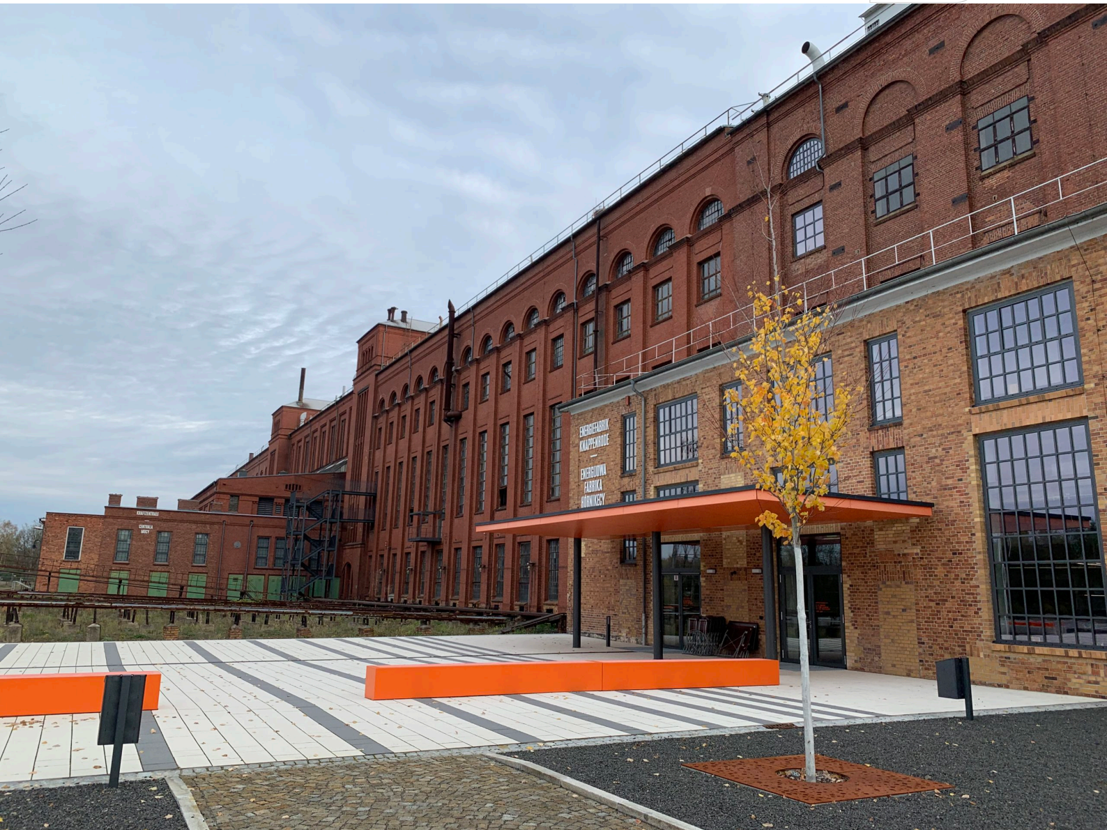
Eingangsbereich der Energiefabrik Knappenrode im November 2022
