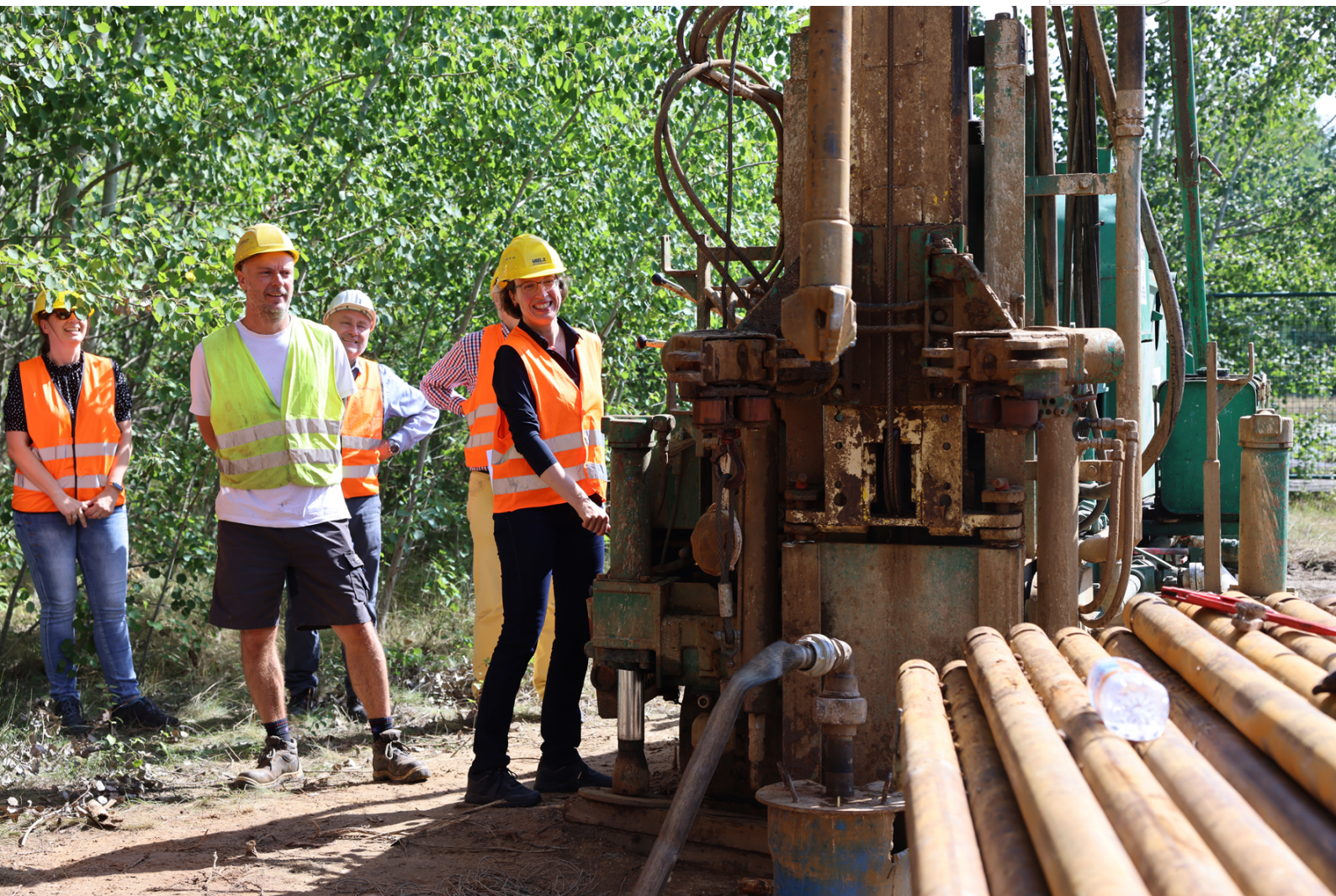
Regierungsdirektorin und Aufsichtsrätin Heike Große-Wilde betätigt den Hebel des Bohrgerätes
