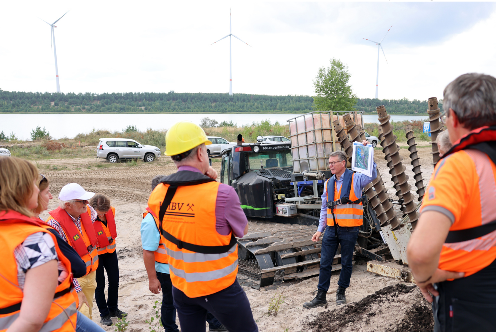
Gerd Richter, Leiter Sanierungsbereich Lausitz, erläutert die Schonende Sprengverdichtung
